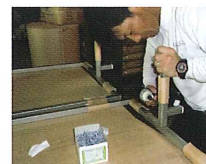
据付・組立作業
